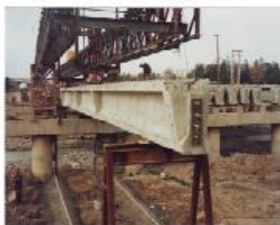
( تیرهای پل پیش ساخته )
