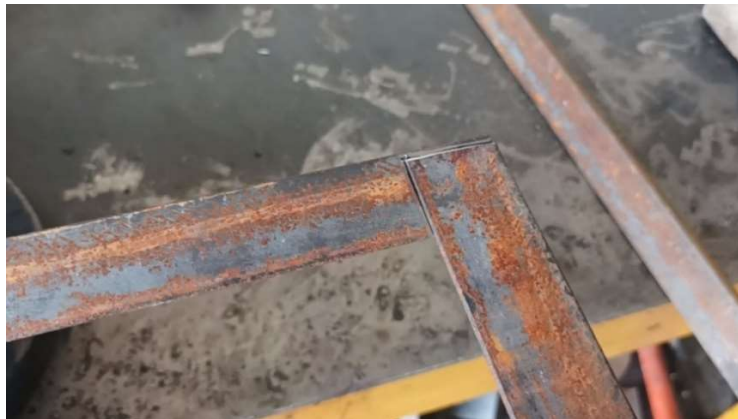
(شکل ۶-۵) آماده سازی نبشی جهت انجام جوشکاری
